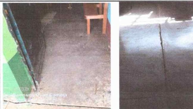
Foto 2: Se observa el deterioro y desprendimiento del piso en varias aulas.
