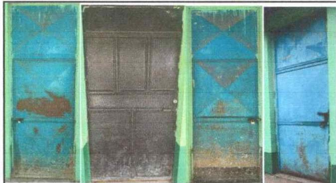
Foto 1: Se observa el deterioro de las puertas de baños y aulas.
